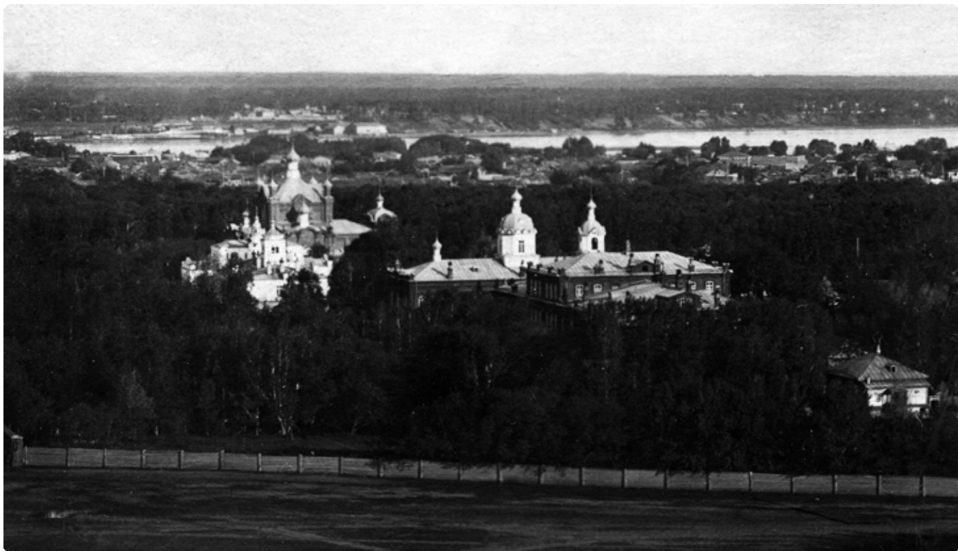
Бийское архиерейское подворье и Бийский архиерейский дом (слева на переднем плане). Фрагмент. 1910-е гг. БКМ
